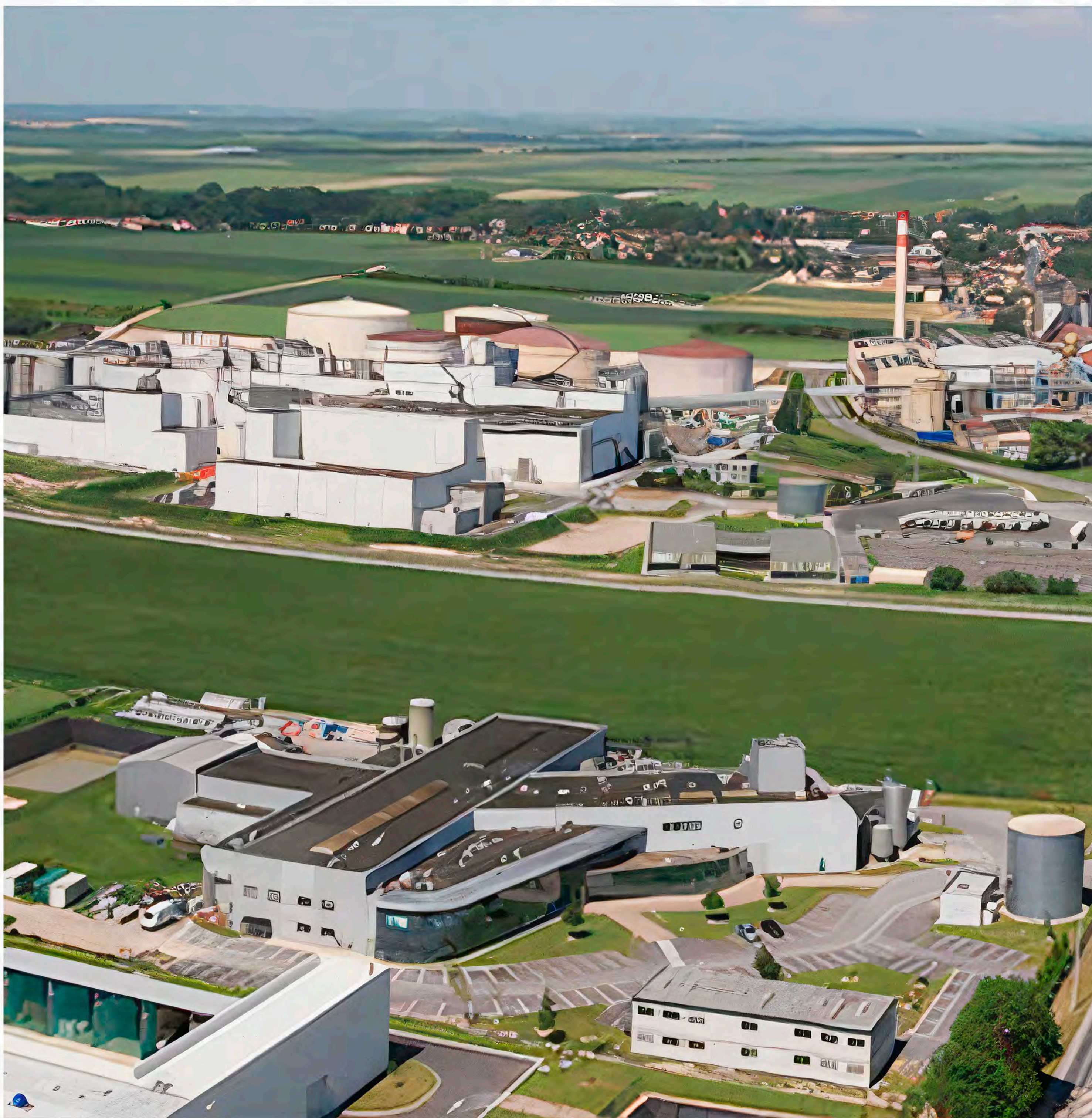
www.grandreims.fr. La bioraffinerie de Bazancourt-Pomacle
